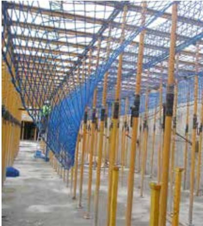
Durante la ejecución del sistema de encofrado, las redes bajo forjado cumplen un papel importante frente a una eventual caída de los operarios, tienen la finalidad de detener la caída del personal durante el proceso de armado del encofrado en el interior de la construcción.
