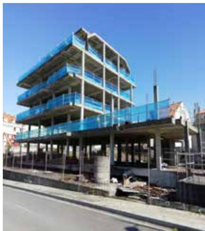
Llamado también sistema perimetral de borde compuesto por barandillas, balustres y rodapiés, cumpliendo los estándares de la normativa UNE 13374, teniendo una función importante de dar protección de caída de personas a pisos inferiores, este sistema provisional se coloca en exteriores de obra, interiores como ductos de ascensor, patios internos, todo lo que tenga que ver como protección de borde.
