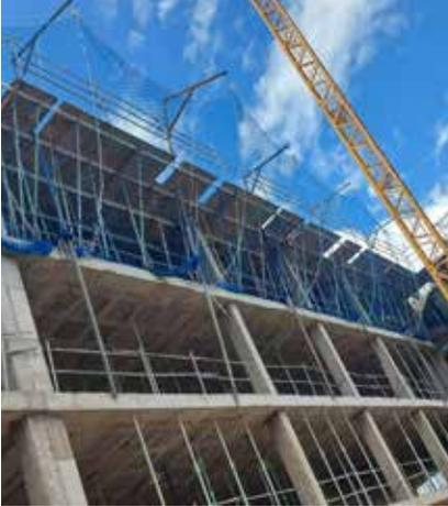
Este sistema de protección colectiva contra caída de personas a distinto nivel, compuesto por una estructura tipo horca y una red tipo V, tiene la finalidad de proteger contra caída y minimizar el impacto de caída de personas a distinto nivel, cumpliendo la NORMA UNE EN 1263-1.
